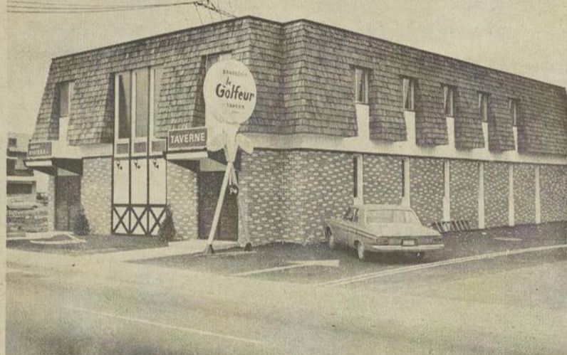
Veduta esterna della Birreria "Le Golfleur" luogo d'incontro degli sportivi
