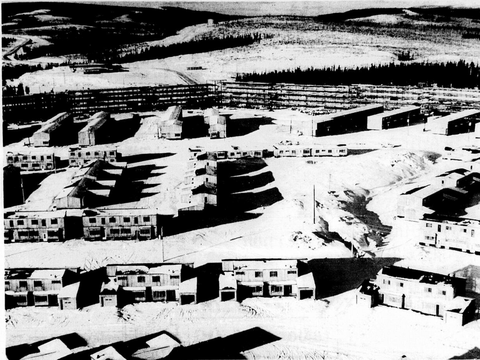
La ville de Fermont en construction qui logera 5,000 habitants. Déjà 300 familles y résident.
