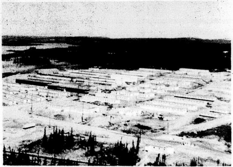
Vue des camps et cuisines qui peuvent accomoder 2,200 travailleurs.
