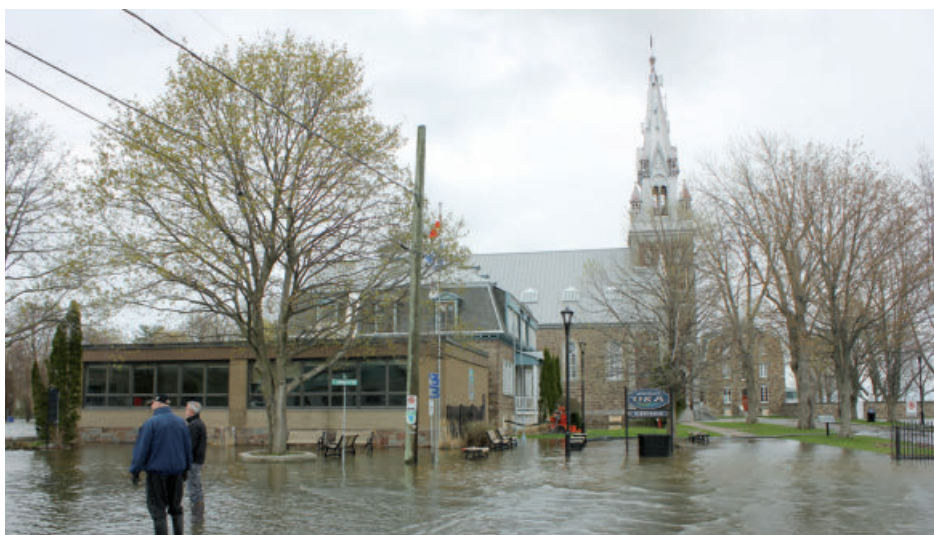
Photo Benoît Bilodeau La mairie d'Oka a été évacuée en raison de l'eau qu s'y est infiltrée.
