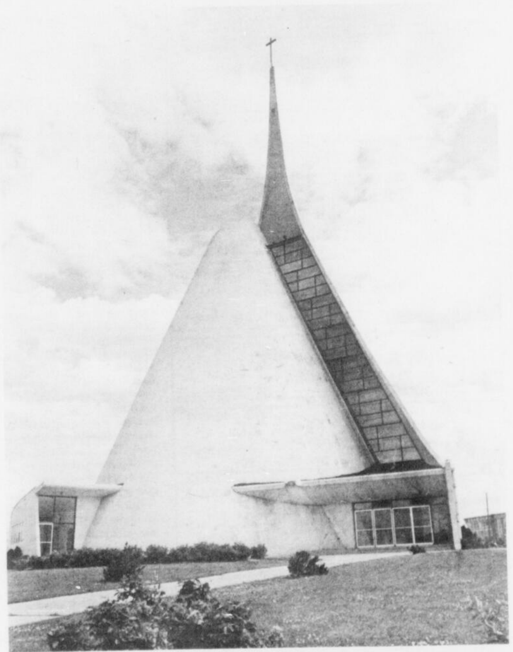
Epousant la forme d'un gros cône renversé, surmonté d'un fin clocher, le sanctuaire Notre-Dame-de-Fatima offre l'aspect et la douceur d'une tente géante ou, grâce à des vitraux de différentes couleurs, s'infiltrait la lumière naturelle pour tomber d'aplomb sur l'autel.
