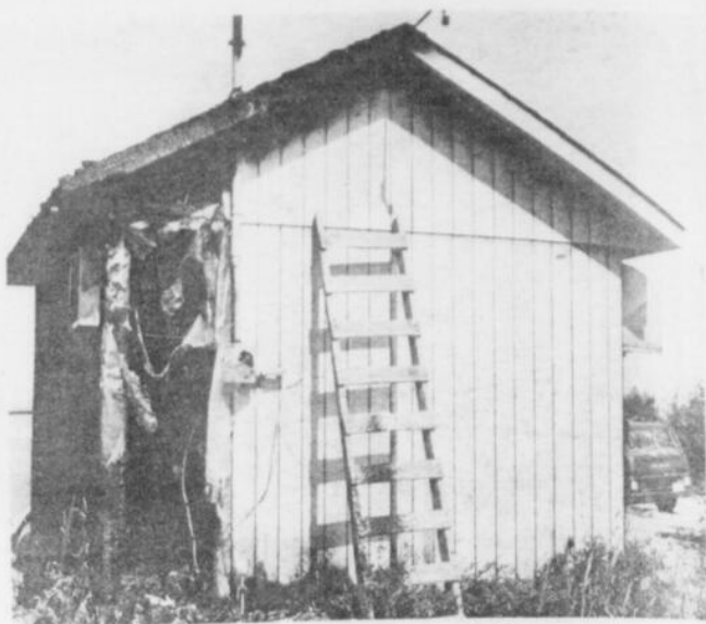
CHVD, DOLBEAU. La bâtisse qui contenait les instruments d'émission a été détruite par les flammes. L'enquête a pu déterminer que le feu a été allumé par des mains criminelles. Les dommages sont évalués à $35,000. L'enquête se poursuit et les pistes sont rares.
