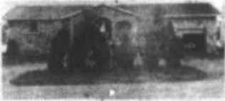
13 — SAINT-MATHIAS — "Bord du Richelieu" - Bungalow style espagnol, pierre et brique, garage, foyer, magnifique terrasse, mur béton, descente pour bateau, Alice Boisvert, 464-1300, 467-1120.
