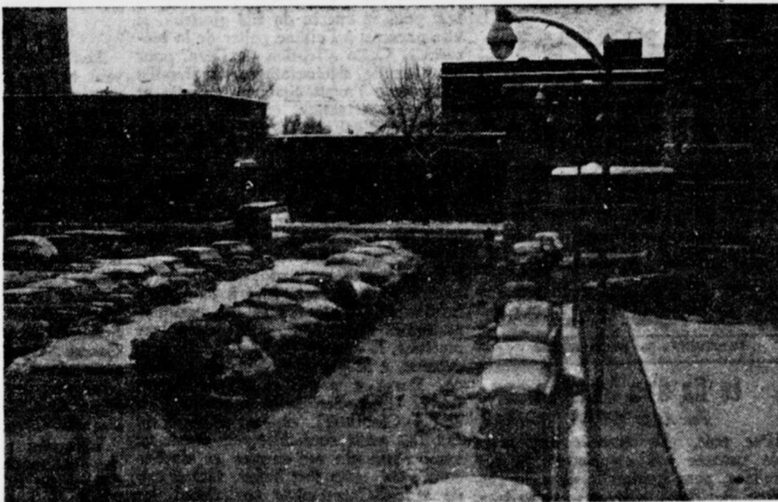
PROTECTION CONTRE LA NEIGE. — Les autorités de l'Hôtel-Dieu de Montréal ont eu recours à la science pour éviter l'enneigement de leur cour de stationnement. Cette cour, d'une superficie de 31.000 pieds carrés, est réchauffée sous terre et la neige disparaît comme par enchantement, n'apportant aucun problème de déblaiement. La photo ci-dessus, prise au cours de la tempête d'hier, démontre les résultats de cette mesure. Alors que les toits des voitures en stationnement sont recouverts de neige, la chaussée est libre. Pendant ce temps, les automobilistes, dans les rues de la ville, faisaient avancer de peine et de misère leurs voitures.
