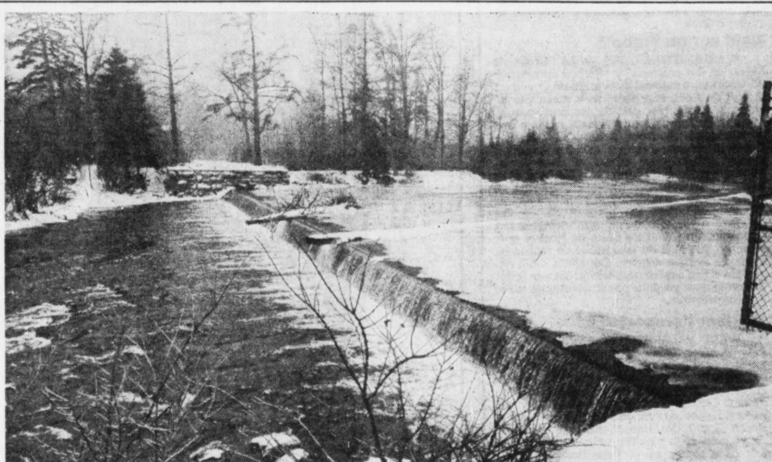
Le Soleil, Reynald Lavoie C'est ce couvercle de glace à la prise d'eau de la ville de Québec qui, s'il venait à se briser, pourrait être emporté par le courant et faire céder les deux embâcles signalés en aval.
