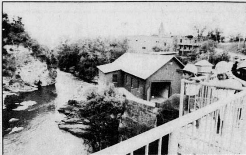
Des attractions parallèles à la Fête sont possibles près du lac des Nations, en bordure de la rivière Magog, dont une visite à la centrale hydroélectrique Frontenac.
