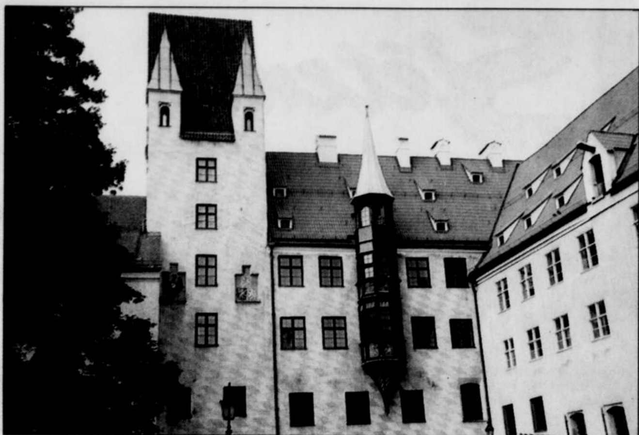
La cour du Vieux Palais et son superbe encorbellement.
