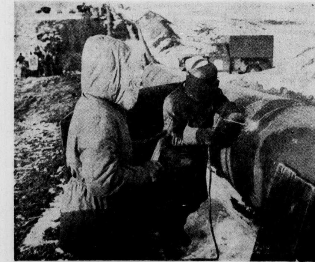
LE PIPE-LINE TRANS-CANADIEN : Les équipes d'hommes qui travaillent à la pose des tuyaux du pipeline de l'Ouest doivent porter des canadiennes, des bottes chaudes et d'autres vêtements d'hiver, à cause du froid glacial qui sévit dans la section occidentale de la conduite de gaz naturel que la Trans-Canada Pipe Lines Ltd construit entre l'Alberta et
