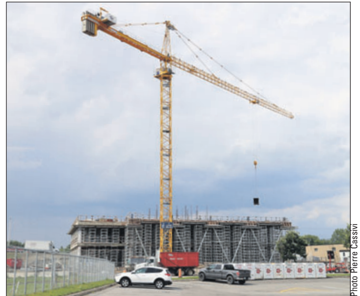
Les travaux du nouveau siège social de la Caisse Desjardins de Sainte-Foy au cœur du projet immobilier ESPACE de Bourgogne vont bon train.
