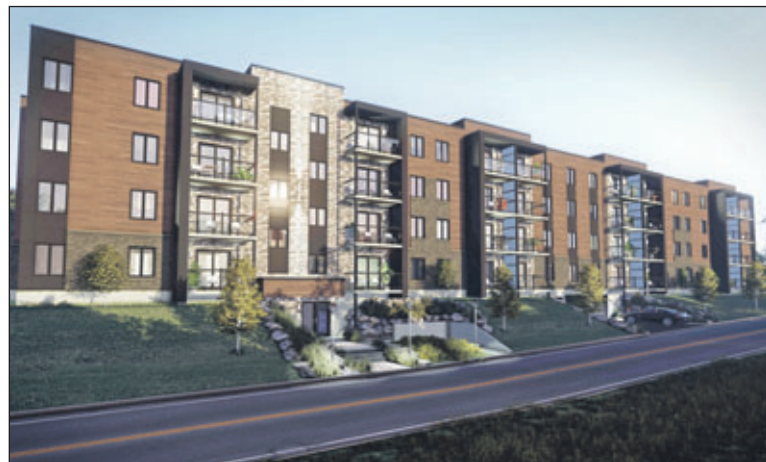
Le 2975 Chemin Sainte-Foy comprendra 60 unités locatives de style condo et la livraison est prévue pour le printemps 2015.
