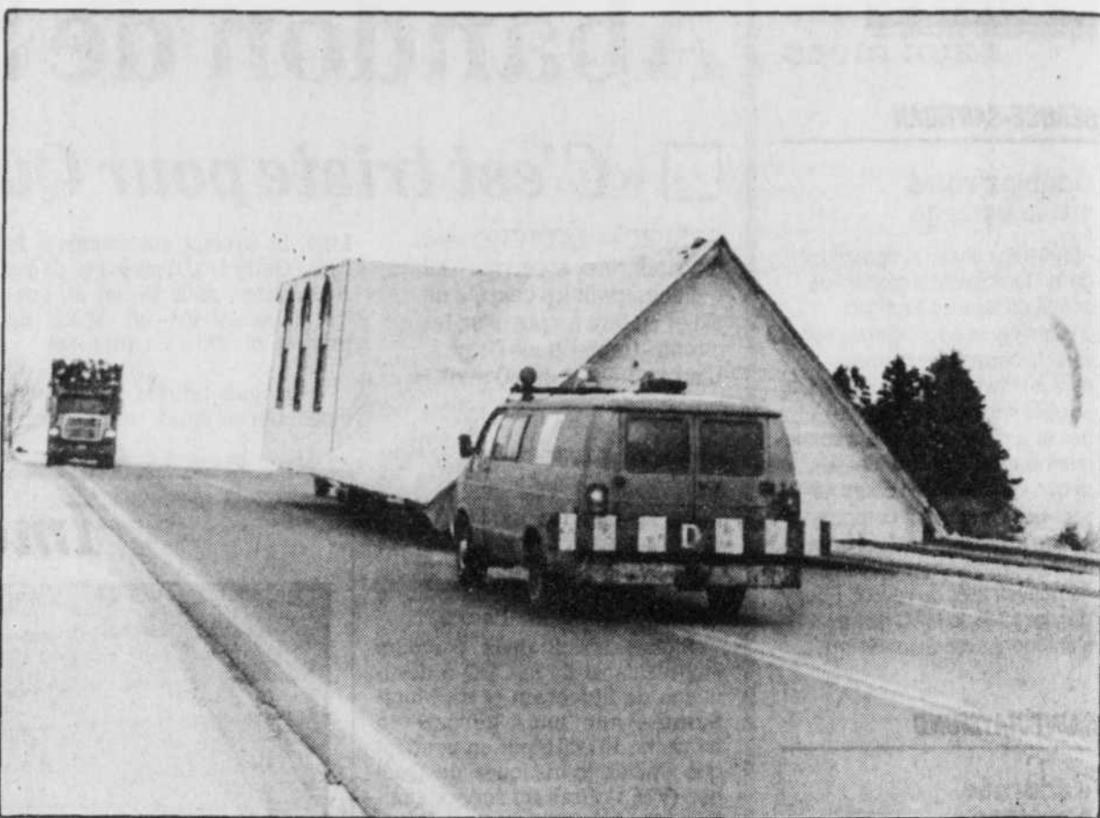
Le déménagement de l'église de Sillarsville a duré plus de six heures. Le convoi circulait à environ 20 km/h. Le toit de l'église a été sectionné et placé sur la même remorque.
