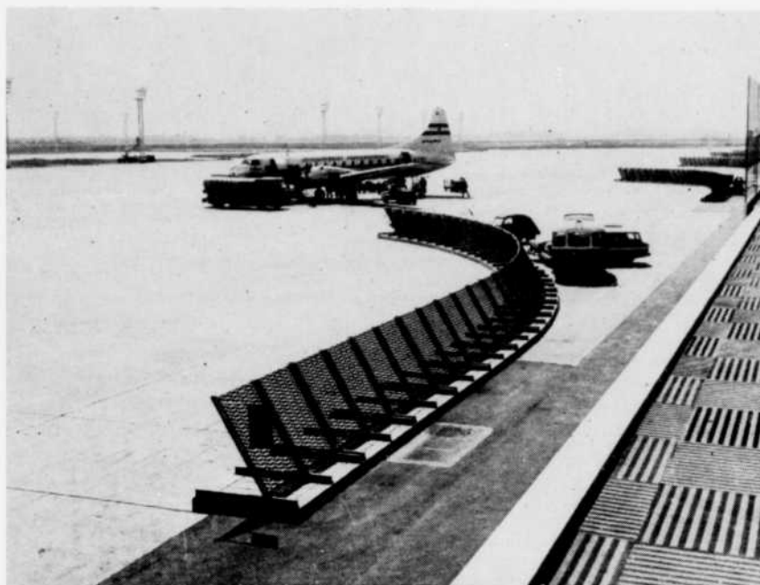
Fig. 2 — Vue d'ensemble d'un écran anti-souffle.
