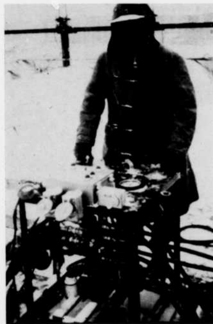
Fig. 6 — Le panneau de contrôle des vérins.
