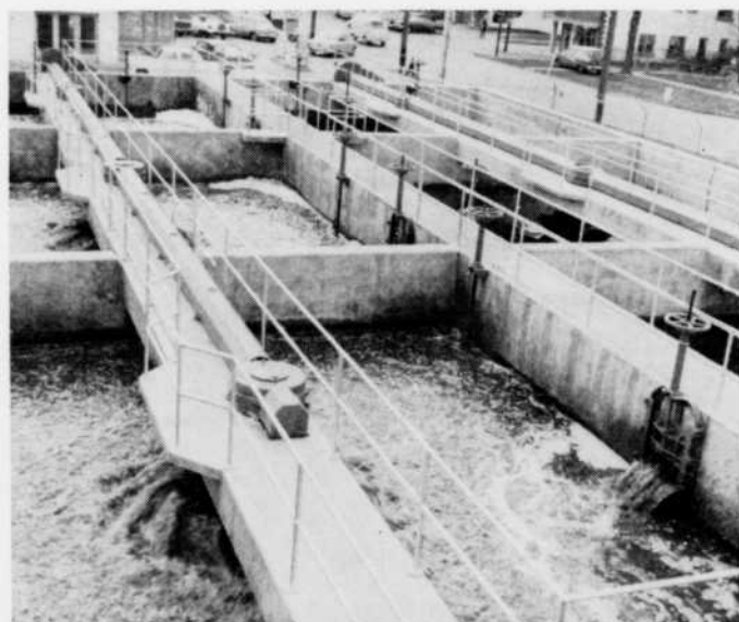
Vue des bassins d'aération mécanique, West Side Plant, Port Colborne, Ontario. Projet : Canadian British Engineering Consultants.
