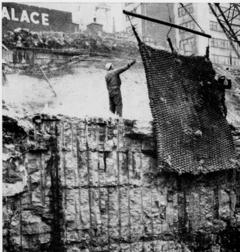
La proximité d'autres immeubles obligeait à réduire les vibrations au cours du creusement des tranchées de fondation de l'immeuble de 42 étages de la Place Ville-Marie, à Montréal. Le découpage préalable a limité efficacement ces vibrations.
