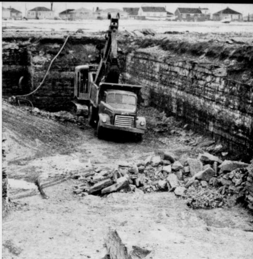
Le découpage préalable a permis d'obtenir des murs de fondation et des gradins rocheux bien lisses, destinés à recevoir du matériel lourd de laminoir. Ces travaux de terrassement ont précédé la construction d'un nouveau laminoir de l'Aluminum Company of Canada Limited, à Kingston (Ontario).
