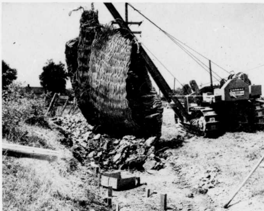
L'utilisation de deux matelas de sautage en acier et caoutchouc, élimine presque tout le vol de roc et les pannes de communication au cours de la construction d'un gazoduc, près de Kingston, Ont.
