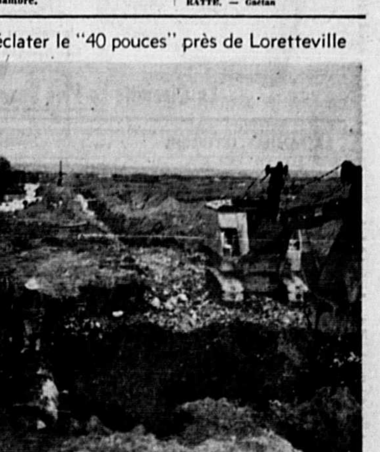
Sur la photo de droite, on voit une équipe d'hommes travaillant à dégager le tronçon crevé. A gauche, on aperçoit la tranchée qui recevra la nouvelle conduite d'amenée de "42 pouces", qui, comme on le constate, est située à proximité du "40 pouces". Bien que les ingénieurs ne se soient pas prononcés, on présume que l'explosion est la cause du bris. L'opération est effectuée avec une très grande promptitude puisque dès ce matin, la circulation de l'eau était rétablie. Ordinairement, des accidents du genre prévient d'eau la population pendant 24 heures. (Photos L'Action Catholique, Roger Bédard.)
