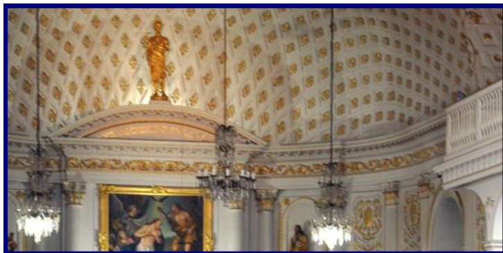
Voûte à caissons
