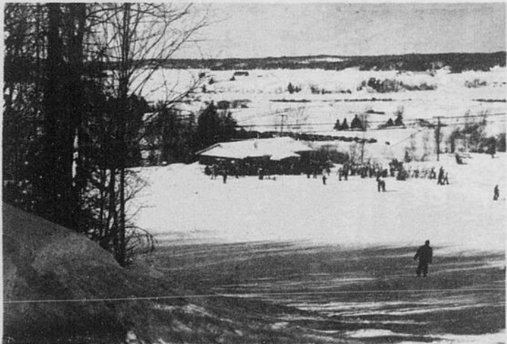
Le chalet de ski, temporairement aménagé en bas des pentes, et qui servira à d'autres fins quand l'immense chalet sera construit, un peu plus à l'est. Celui-ci fait bien l'affaire pour cette année, et on y trouve le guichet des billets et le restaurant, de même que des toilettes.
