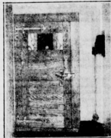
On voit ci-dessus la porte massive et fortement verrouillée qui donne accès à l'une de nos vôtés à air froid. A remarquer le thermomètre visible à travers la porte vitrée, enregistrant une température moyenne de 33°.
