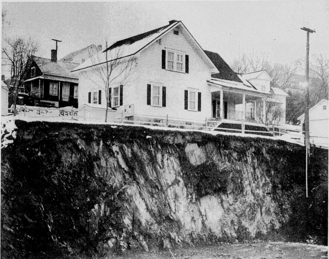
Tombera-t-elle? oui ou non? Telle est la question que plusieurs lecteurs se poseront en voyant la résidence de M. Réal Poulin de St-Georges perchée au-dessus d'une béante excavation. N'ayez crainte: la maison est cons-
