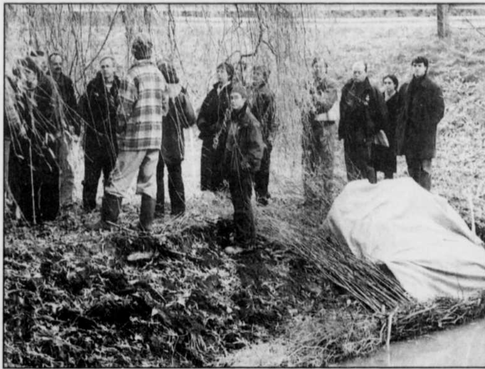
On aperçoit ici la méthode utilisée par le COVABAR pour revitaliser les berges du ruisseau Bernard. Elle consiste à disposer sur la berge un lit de branches qui reprendront racine au printemps et assureront un couvert végétal sur le bord de l'eau.
