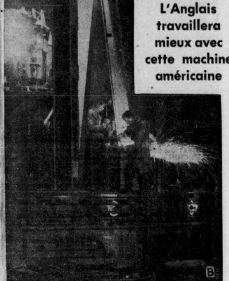
Le que l'on voit ici est une partie seulement d'un gigantesque "excavateur" de mine, d'un poids total de 455 tonnes, qui vient d'arriver des Etats-Unis en Grande-Bretagne. Il a fallu 50 camions pour en transporter les divers morceaux, du port de débarquement jusqu'au site définitif de travail de cette énorme machine et des équipes de soudeurs ont travaillé jour et nuit pendant deux semaines à rassembler et consolider le bâti. Les Anglais ne travaillent avec tant d'énergie que parce qu'ils ont hâte, à même les secours du Plan Marshall, d'avoir rétabli leur économie nationale au point de pouvoir se passer de l'aide américaine.
