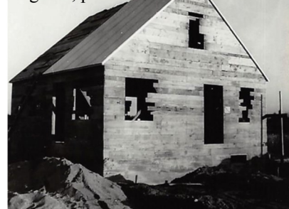
2 e maison en construction à Buckingham, par Charlie
