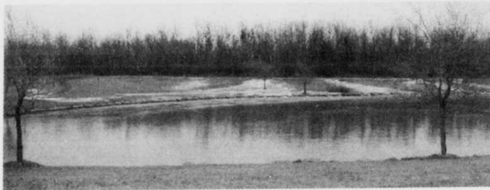
Depuis quelques années, des inondations se produisent au Parc de la Cité en raison des pluies diluviennes et des problèmes d'équipements aux stations de pompages.
