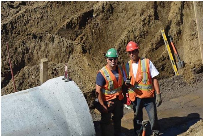
Dany Duguay et Akian Sioui, travailleurs sur le chantier Photo : Jean-Philippe Vincent
