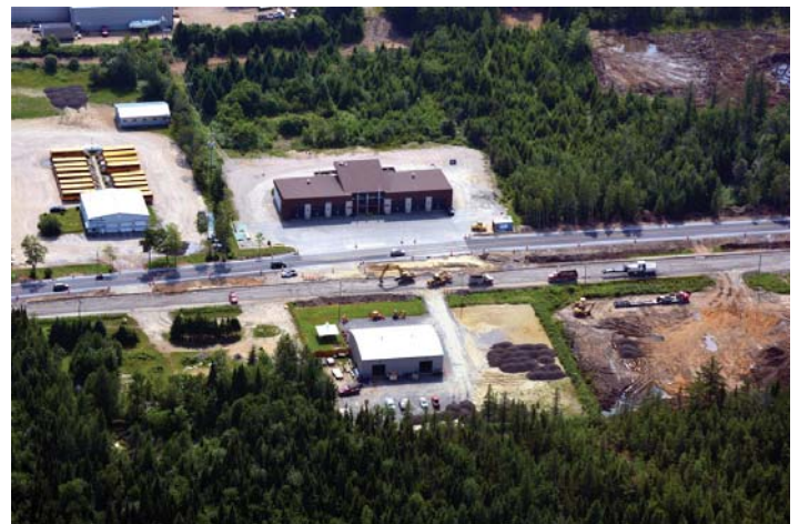
Vue aérienne du chantier Photo : Jean-Philippe Vincent
