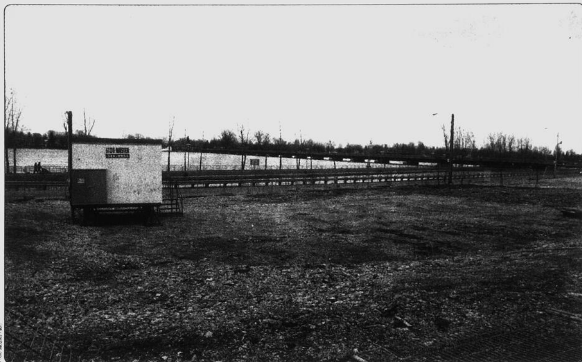
Le chantier d'aménagement de la grande place du centre-ville sera parachevé à la mi-août.
