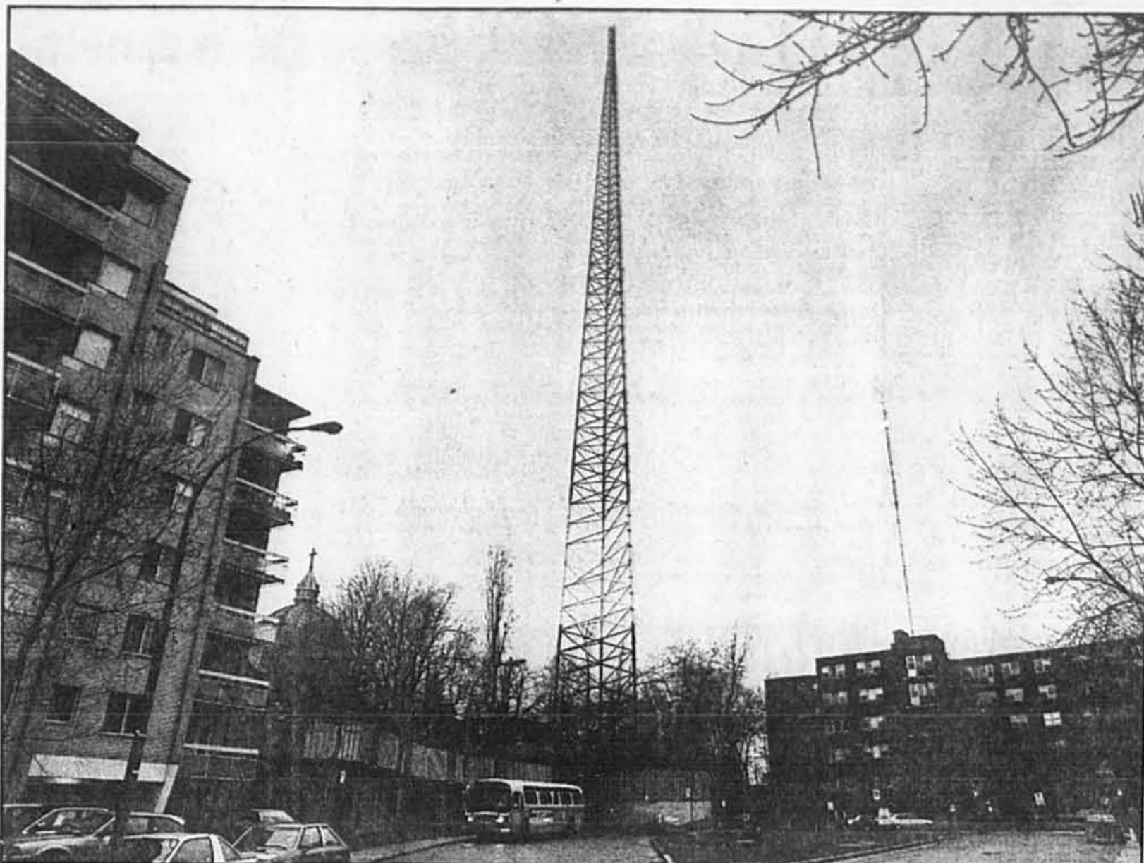
Bien installée entre deux immeubles résidentiels, la tour de communications de la compagnie Gleyrare surplombe même la coupole de l'Oratoire Saint-Joseph, un véritable acte de mépris pour le patrimoine québécois, selon le conseiller Abe Limonchik.
