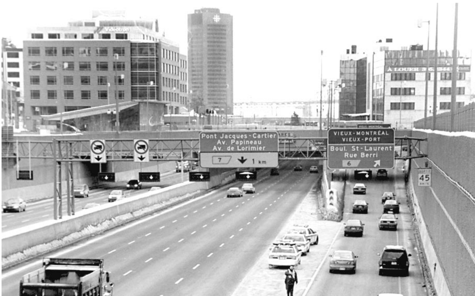
Une vue de l'autoroute Ville-Marie, vers l'est, depuis la rue Saint-Antoine.
