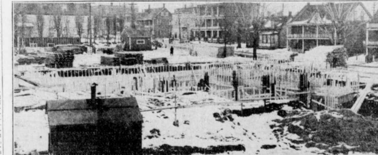
Ecole Technique — Des travaux de fondations sont commencés, mesurant 225 pieds sur 200 pieds de largeur. Elle sera construite en briques, avec charpente en bois, comprendra 12 classes, 1 salle à dessiner, 1 laboratoire, 5 salles, 1 salle de récréation, etc. Les architectes sont MM. Alphonse Bélanger et Jean-Paul Andit. L'entrepreneur est M. Cyrille Michaud.
