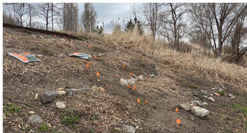
Secteur des berges en restauration. Photo de Karine Manoli.
