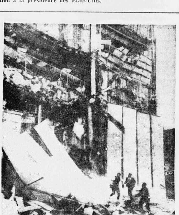
(Téléphoto PA) — TREMBLEMENT DE TERRE EN ALASKA — Plusieurs édifices se sont effondrés à Anchorage, principale ville de l'Alaska, lors du terrible tremblement de terre qui a secoué cet État américain en 1964. Il s'agirait, selon plusieurs, d'un des pires désastres naturels de la décennie.
