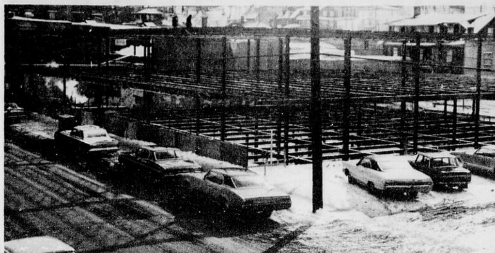
PROGRES DES TRAVAUX: Le centre commercial du centre-ville de Chicoutimi est en train de renaître de ses cendres. Détruits l'hiver dernier au cours de deux incendies désastreux, plusieurs établissements commerciaux reprendront leur place sur la rue Racine. De chaque côté de cette voie commerciale les travaux vont bon train. La semaine dernière la toiture a été posée sur cet édifice que fait construire la firme Grovenor's Investment.
