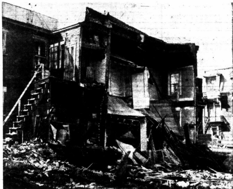
Cette maison de deux étages qui s'est partiellement effondrée à la suite de travaux d'excavation effectués sur un terrain voisin, devra être totalement démolie. Elle n'est plus habitable. Les locataires étaient chez eux au moment de l'effondrement, mais ils en sont sortis miraculeusement sains et saufs. La maison est située au coin de Berri et de Roy, dans la métropole.
