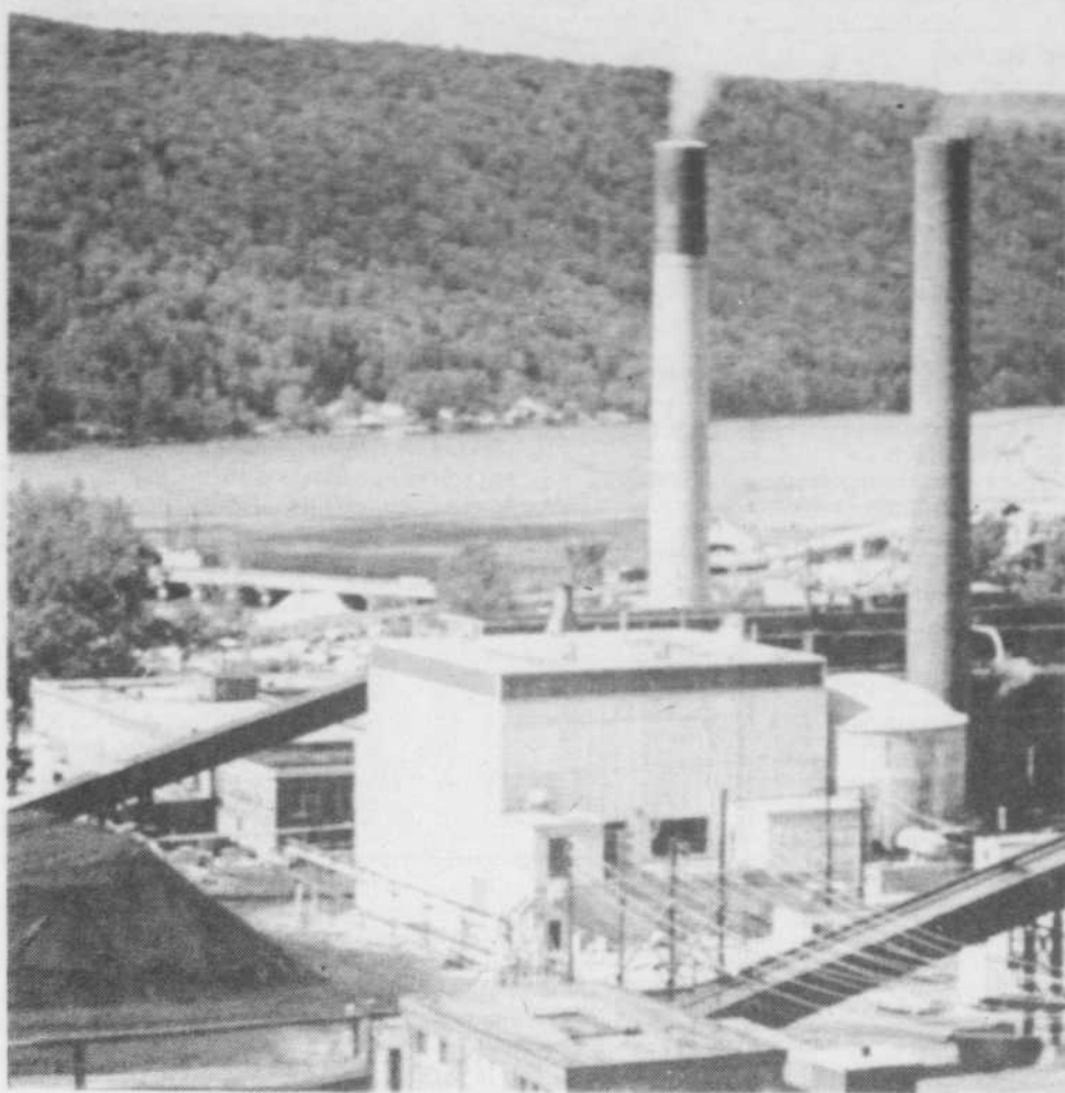
Le nouveau bâtiment de récupération de Tembec mettra l'entreprise à l'abri des pressions inflationnistes causées par la hausse des prix des combustibles. Tembec compte ainsi réduire de $6 millions par année ses dépenses en énergie et en matières premières.
