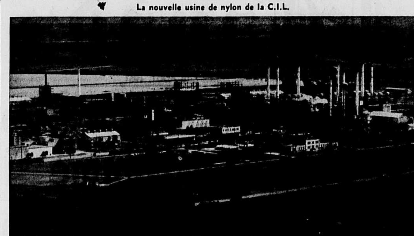
Voici l'aspect que prendra la nouvelle usine destinée à la fabrication des matières premières du nylon, une fois terminée dans deux ans. La Canadian Industries Limited doit en commencer incessamment l'érection sur un vaste emplacement de 1,500 acres qu'elle s'est récemment procuré sur les rives du St-Laurent, entre Brockville et Prescott, Ont.
