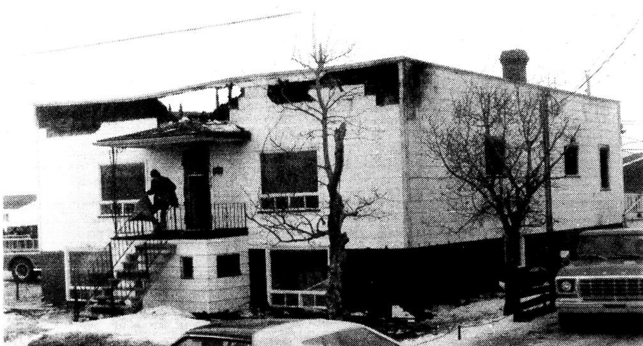
La propriété de M. Valmont Langlois située au 470 St-Pierre dans la paroisse Bon-Pasteur, est une perte complète. (Photos Romain Pelletier)
