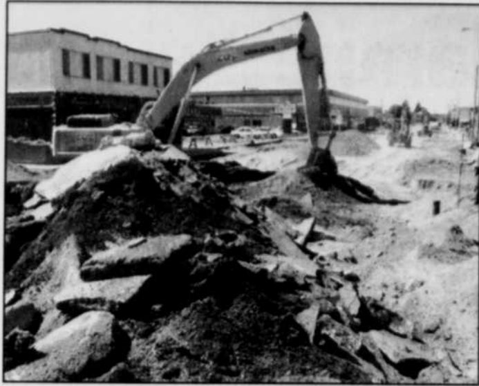
(Image-Média: Patrick Beauchamp) Les travaux de réfection d'une partie du boulevard Sainte-Madeleine devraient être complétés d'ici au 7 août. Une deuxième phase devrait être entreprise l'an prochain.
