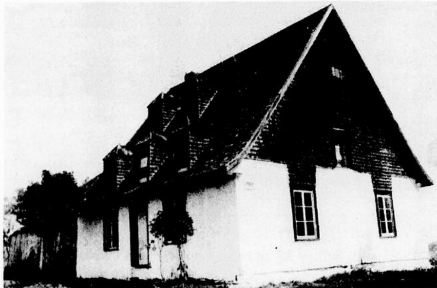
A titre de locataire et de gestionnaire du manoir Dénéchaud, la Corporation du Havre de Berthier-sur-Mer a autorisé l'exécution de travaux mineurs pour éviter que la bâtisse ne tombe en lambeaux avant que le gouvernement ne fasse part de ses intentions à son sujet. Et semble-t-il que le vandalisme, l'une des causes du délabrement du manoir, a cessé. La Corporation d'ailleurs entend bien faire la chasse aux vandales si elle a vent qu'on a frappé à nouveau.
