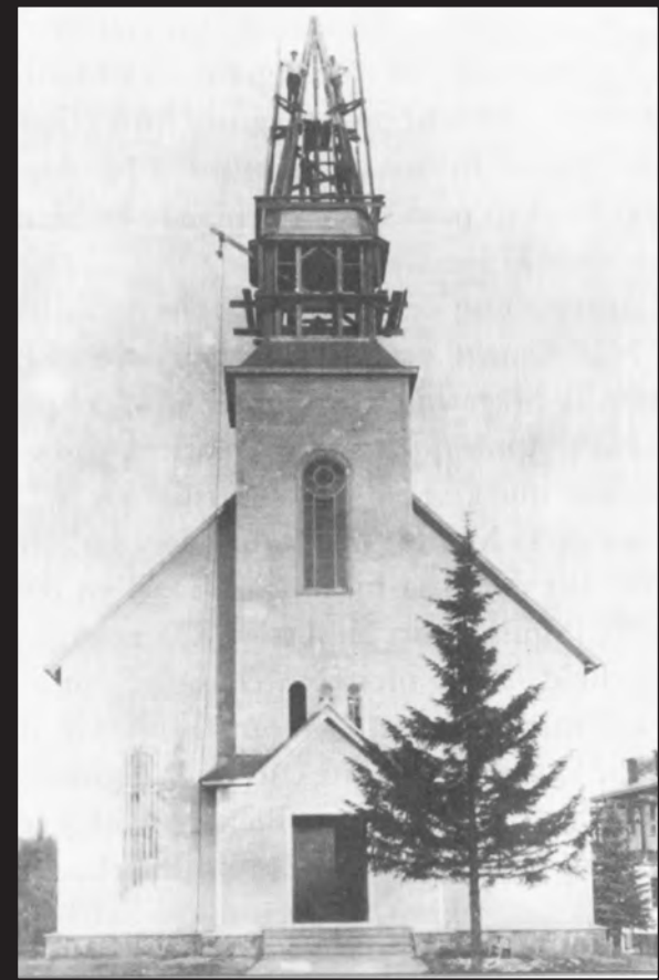
Construction du clocher. Source : Marie-Andrée Dufresne, Val-David. Fragments d'histoire, Val-David, 1996, p. 36
