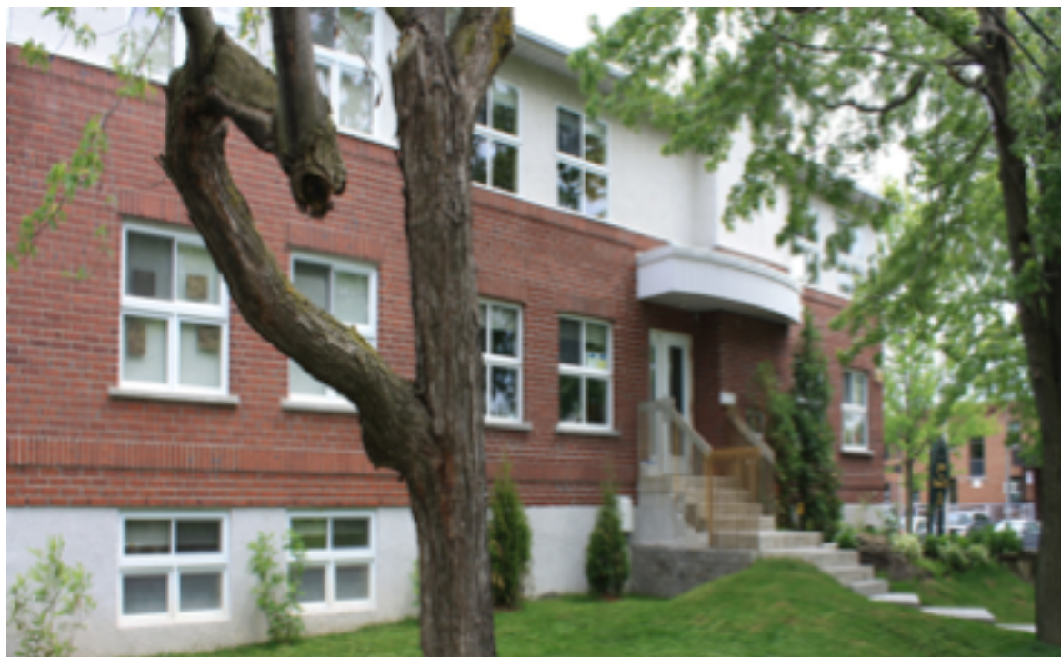
Installation Le Jardin des Boutons d'Or rue Coderre
