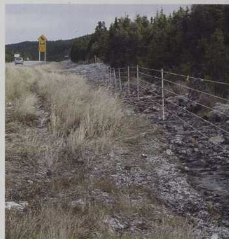
Sur 15 km, une clôture électrique anti-original a été installée.
