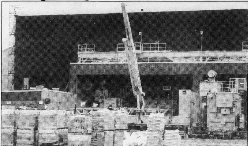
Le Poste électrique, au nord-est du site. Les premiers transformateurs-redresseurs sont en place devant les deux bâtiments des salles de cuves de la série longue d'un kilomètre.
