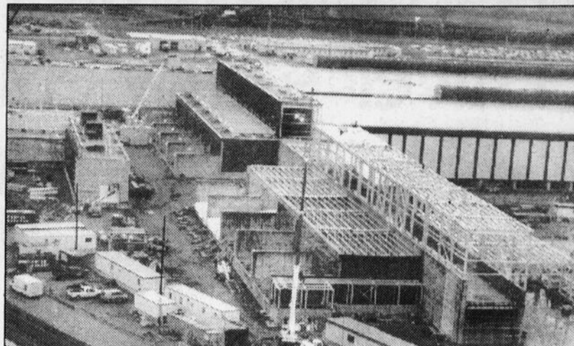
Le Poste électrique, au nord-est du site. Les premiers transformateurs-redresseurs sont en place devant les deux bâtiments des salles de cuves de la série longue d'un kilomètre.
