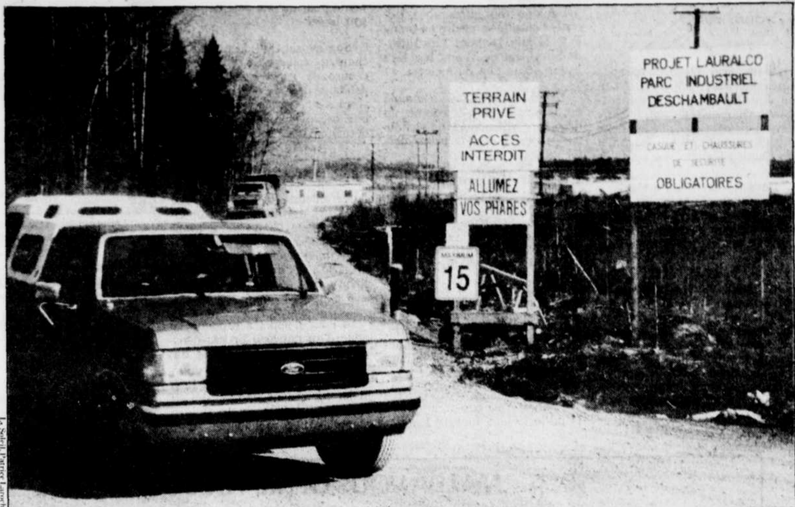
Il n'y avait pas beaucoup de circulation à la sortie du chantier de Lauralco, hier. Maintenant que le permis de construction est accordé, les effectifs du chantier atteindront 1800 personnes au plus fort des travaux.
