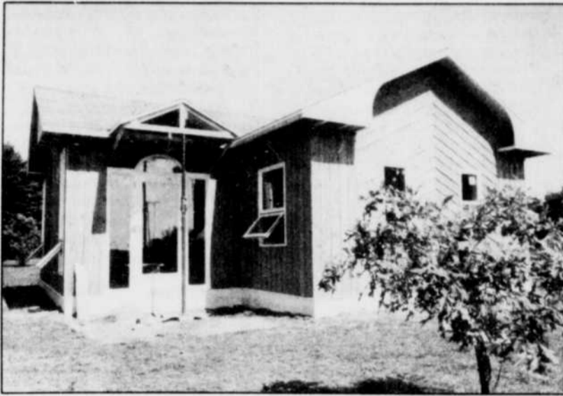
Le nouveau bureau de renseignements touristiques de la Chambre de commerce de Shawinigan et Shawinigan-Sud, dont la construction est pratiquement terminée, à une halte de l'autoroute 55.
