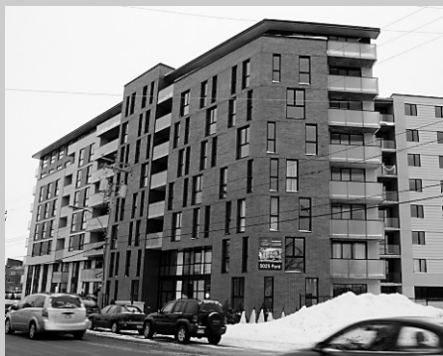
Côté Ouest Penthouse occupe les deux étages supérieurs de la deuxième phase du complexe Côté Ouest.
