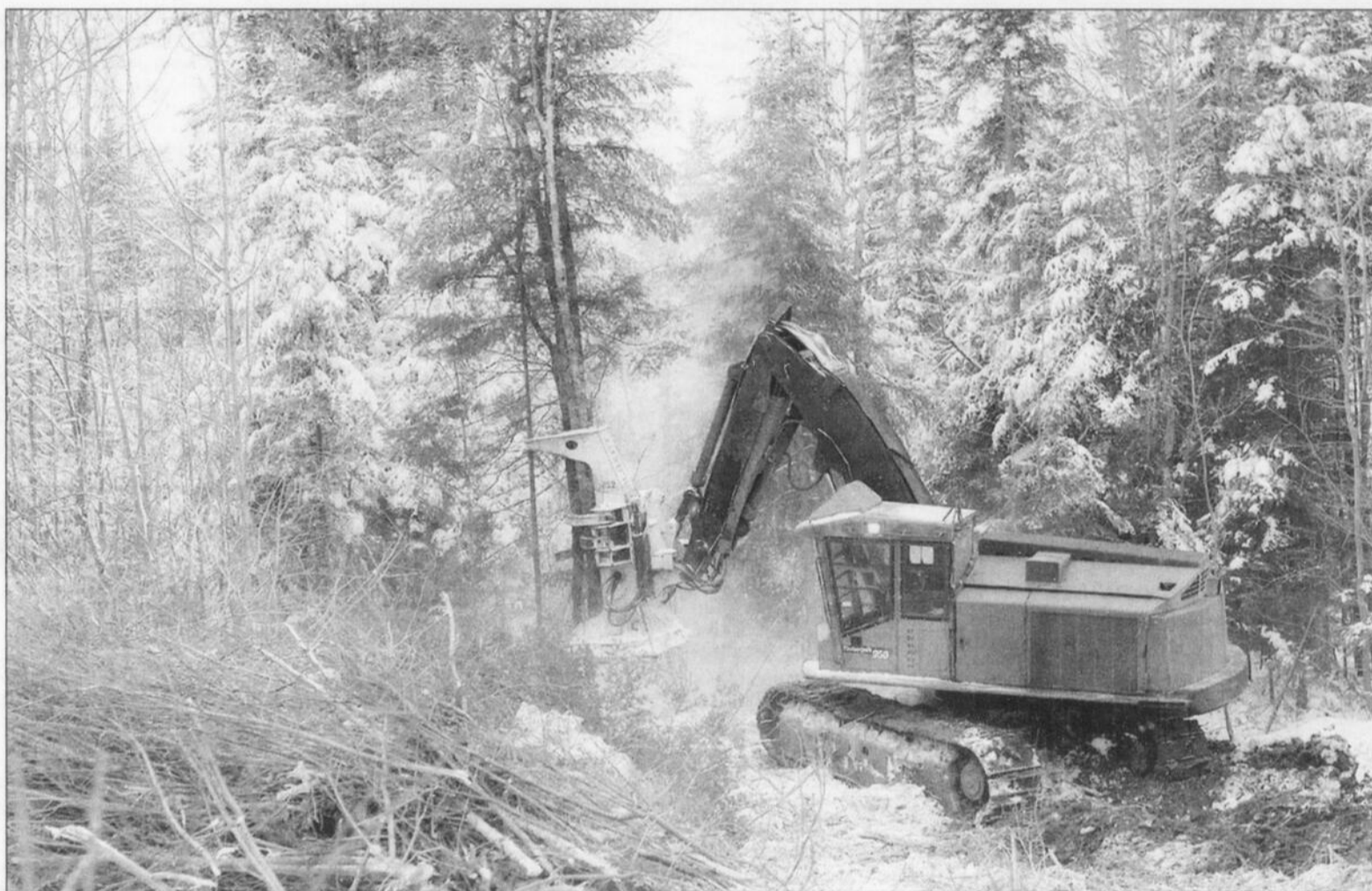
TRAVAUX - Le plus gros chantier au Québec cette année sera l'élargissement de la route 175 entre Québec et le Saguenay. Une première: on a même fait du déboisement en plein hiver pour accélérer le chantier.
