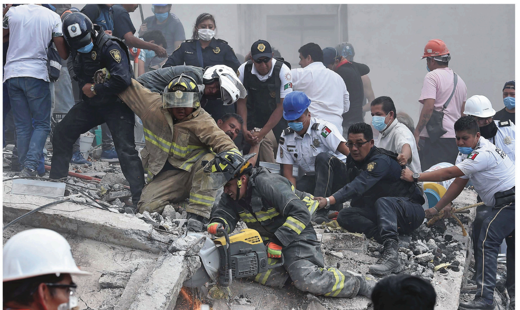
Des secouristes dégagent les débris d'un bâtiment écroulé à Mexico afin de sauver des survivants du séisme.
