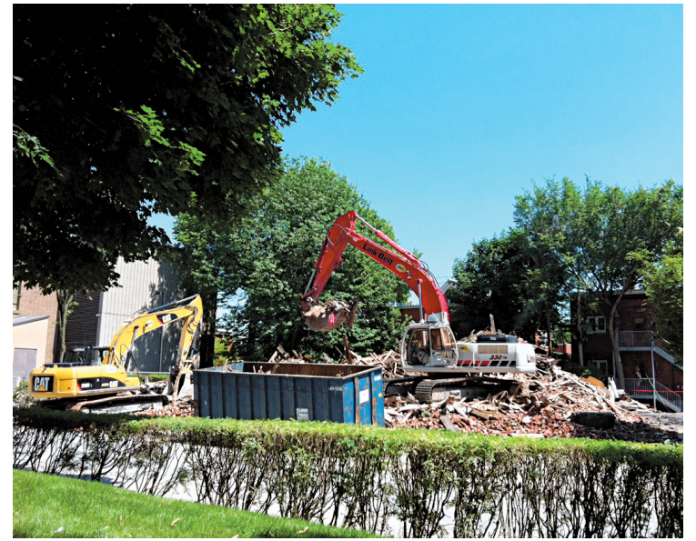
La Maison Dessaulles de Saint-Hyacinthe est tombée hier matin sous le pic des démolisseurs.
