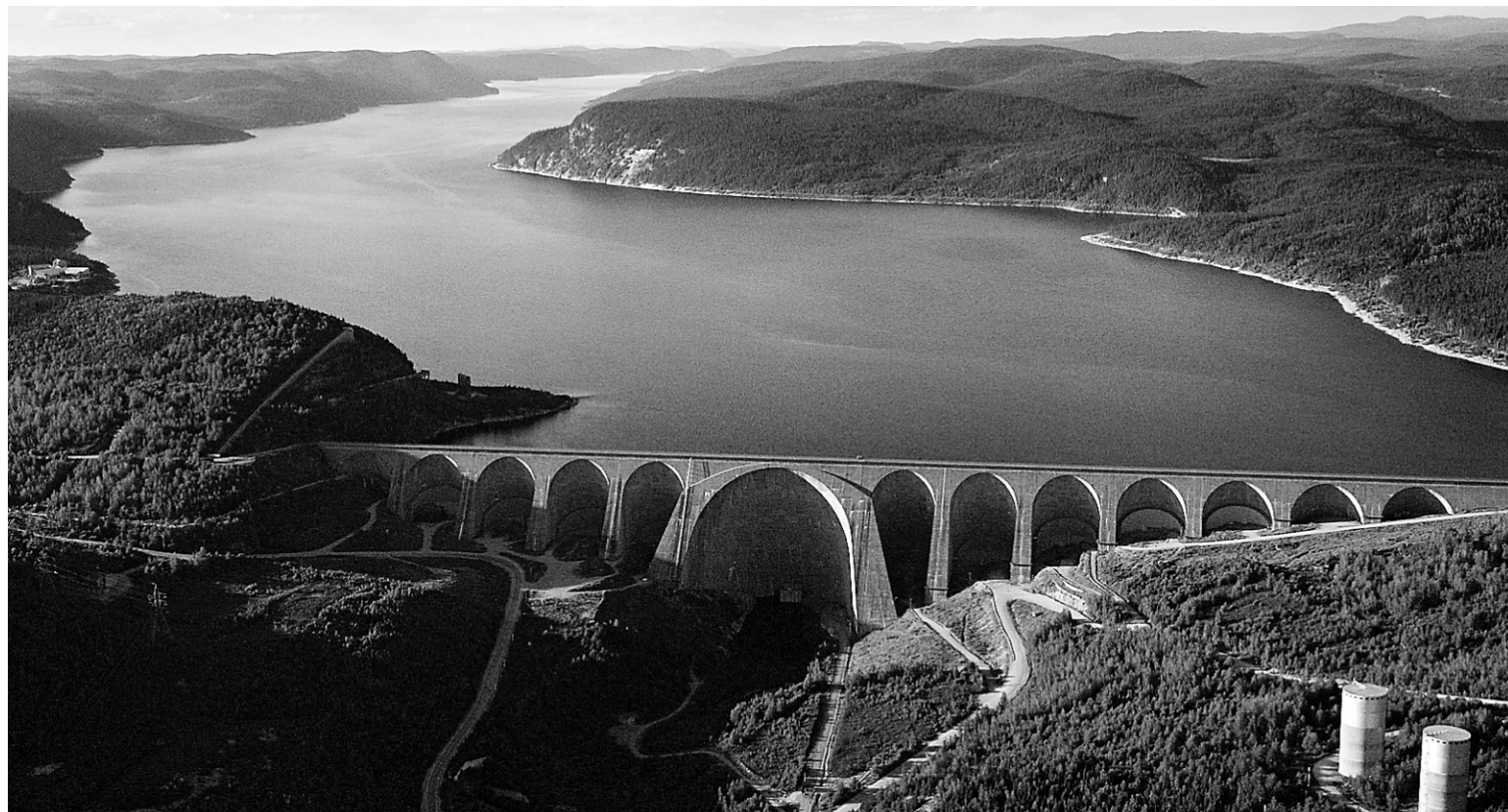
L'hydroélectricité québécoise est moins coûteuse et moins polluante à produire que l'électricité au mazout et au charbon qui est aujourd'hui produite au Nouveau-Brunswick. Sur la photo, le barrage Manic 5.
