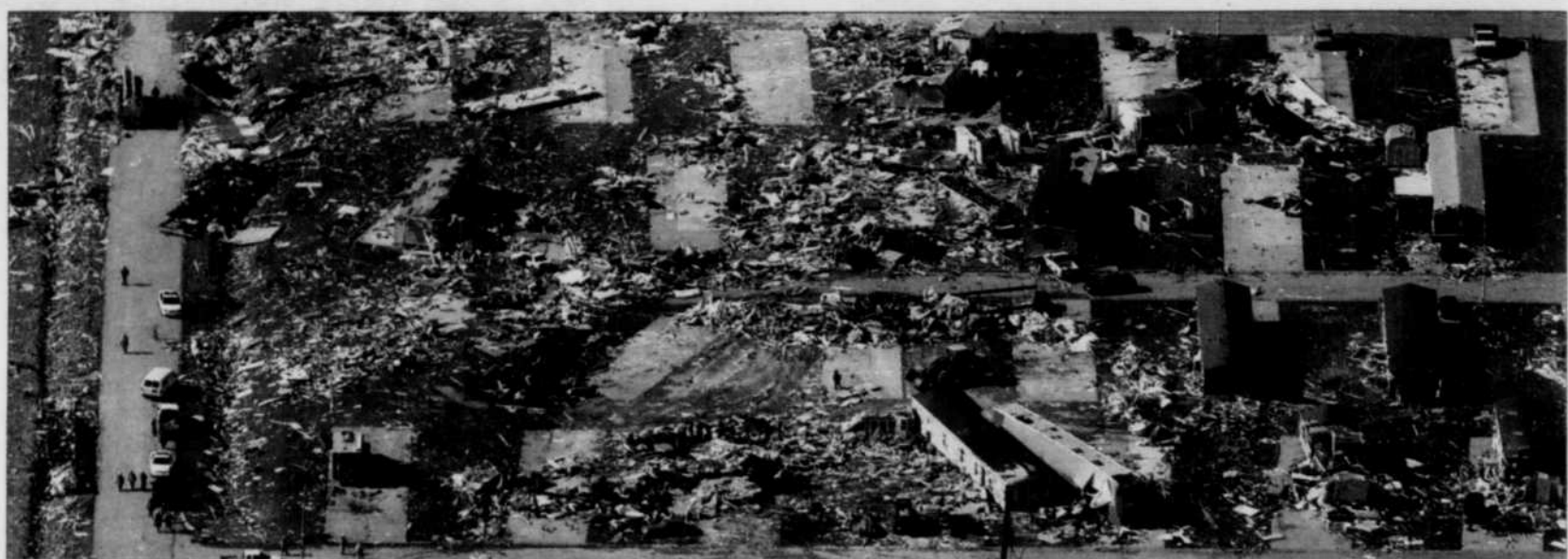
La majorité des décès causés par la tornade ont été rapportés dans le parc de maisons mobiles Eastbrook où près de 350 maisons ont été détruites et 125 autres endommagées.
