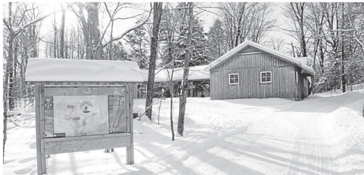
Le projet de construction d'un bloc sanitaire au Domaine du lac Gale progresse. La principale option consiste à ce que le bâtiment soit érigé à proximité du chalet principal. — PHOTO JANICK MAROIS
