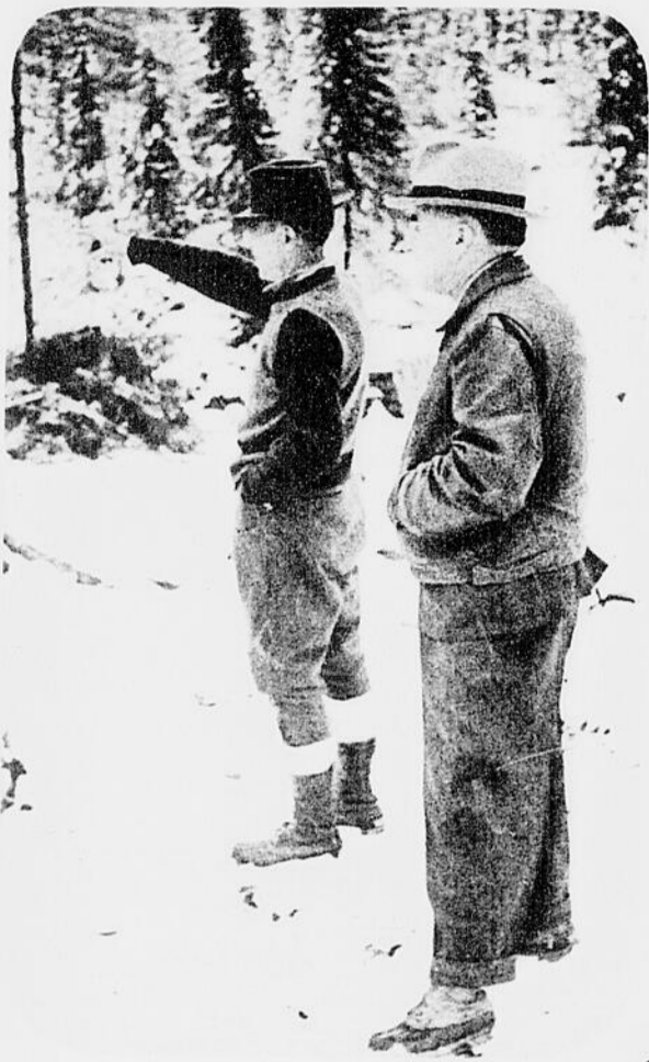
M. Crête (à dr.) au chantier.
